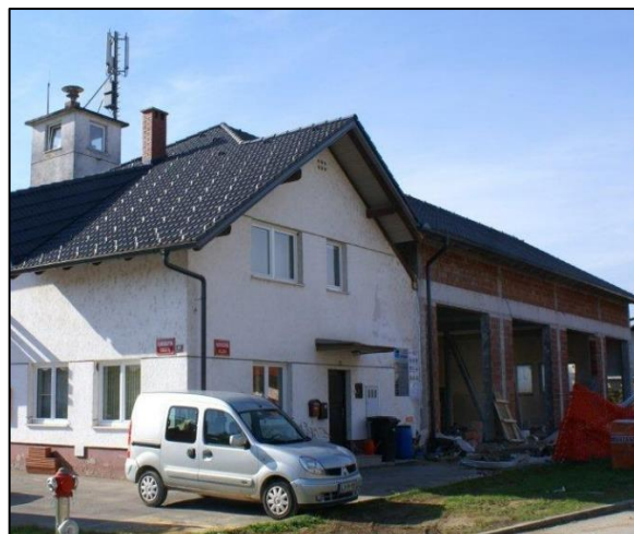
Gradnja prizidka gasilskega doma
