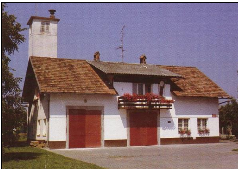
Gasilski dom zgrajen leta 1960
